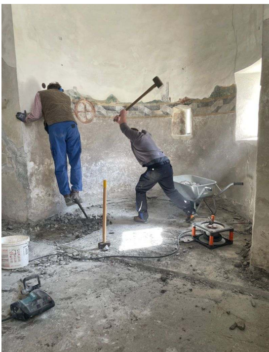
Abbrucharbeiten im Innenraum: Peter Mayer und Georg Groder in Aktion
